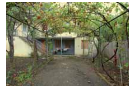
Budova opraveného Denního centra pro seniory Gvirila
